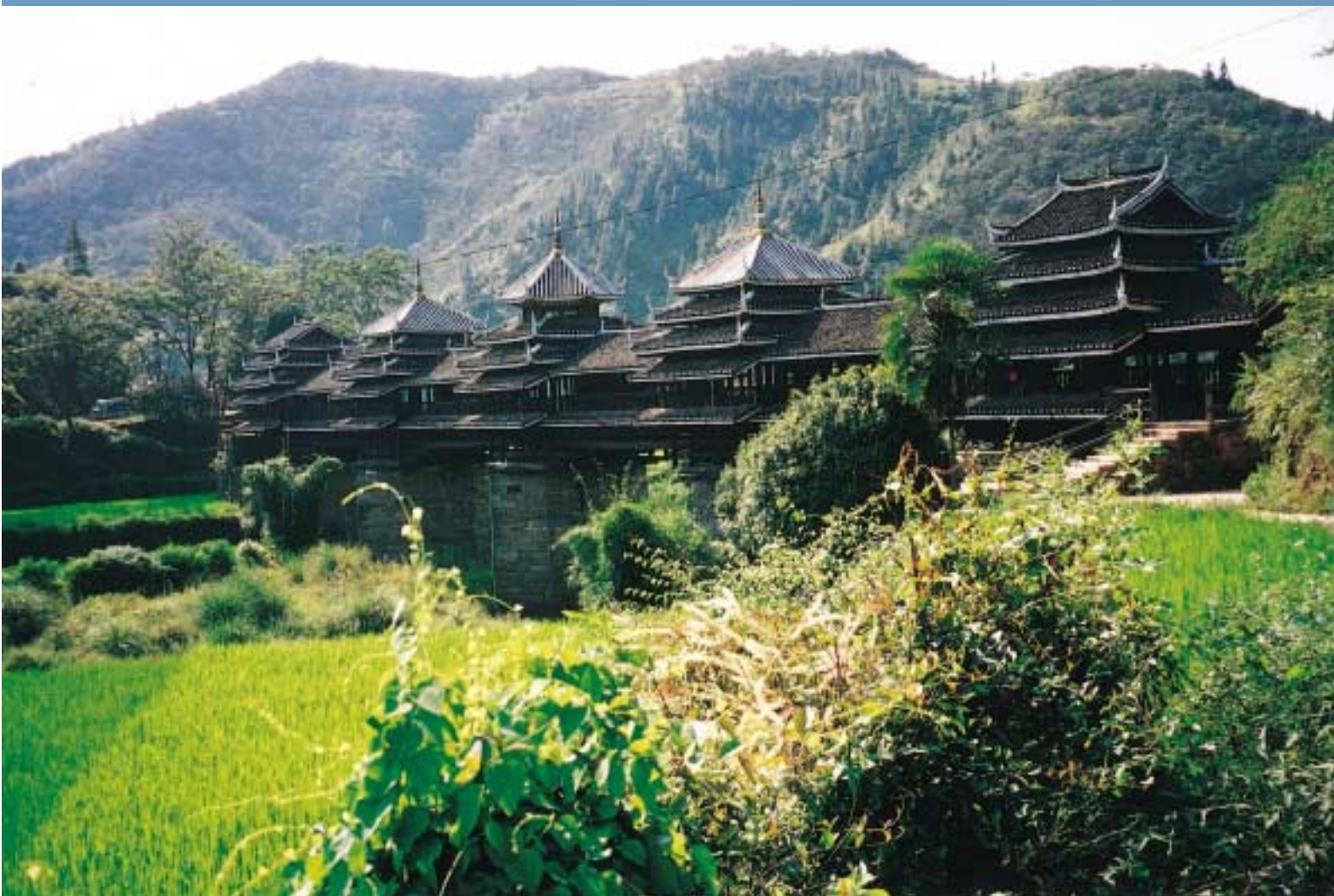
トン族の村の入口に架かる風雨橋
