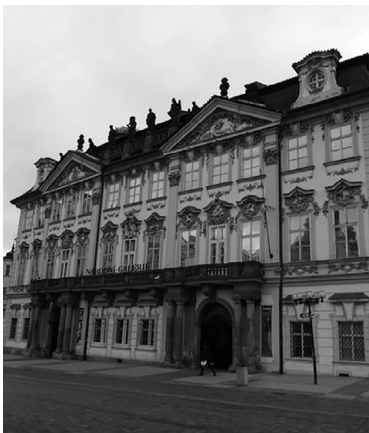
図3 旧市街広場に面したキンスキー宮殿外観
