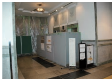
美術館のエレベーターも一部閉鎖され工事専用
