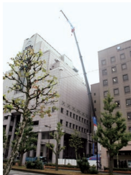
ポケットパークに設置された大型クレーン
